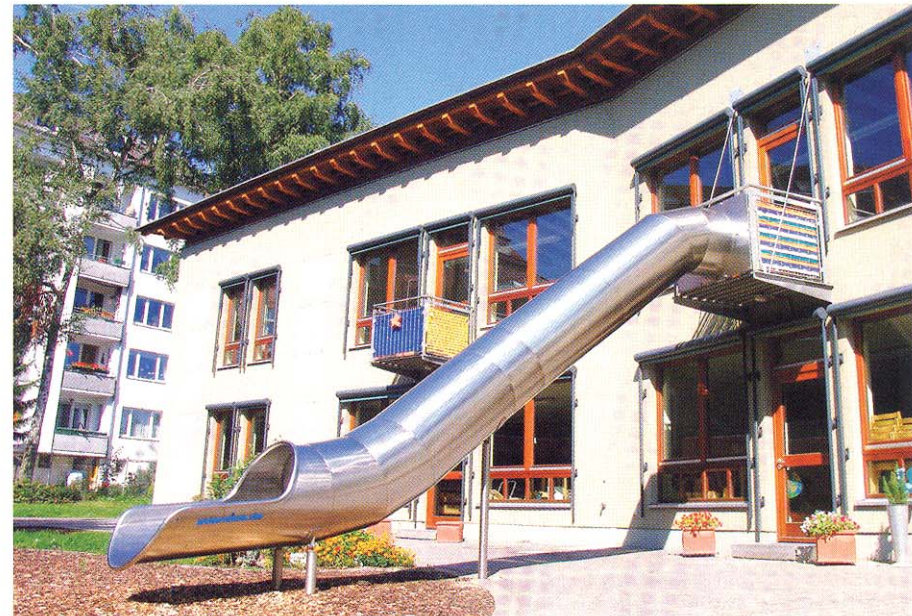
Evakuierungsrutsche und Spielgerät in einem: In einer Kindertagesstätte in Gotha installierte die Firma atlantics® diese Edelstahlrutsche. Nicht nur die Kinder, sondern auch die Feuerwehrmänner waren begeistert.
