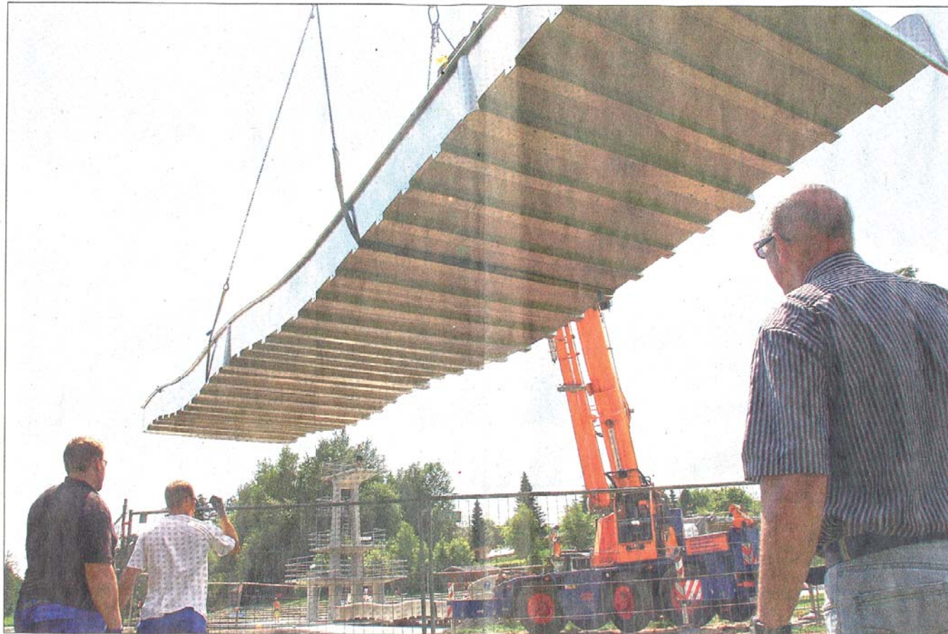
Mit einem riesigen Kran sind gestern die beiden Teile der Wasserrutsche im Marktredwitzer Freibad vom Tieflader gehievt worden. Unser Bild zeigt das untere, 14 Meter lange Teil, das bis zur Montage des Podests auf dem Rasen abgelegt wurde. Weitere Fotos unter www.frankenpost.de . Fotos: zys
