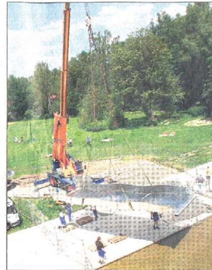
Vom Zehn-Meter-Sprungturm hat man den besten Ausblick, als das obere Teil der Rutsche neben dem Schwimmbecken platziert wird.
