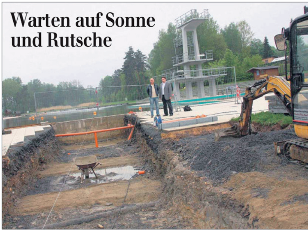
Bahn frei für die Rutsche: 205 Meter Wasserleitung sind vom Pumpenschacht bis zum Beckenrand im Naturbad bereits verlegt. Ende Juni sollen Jung und Alt laut Bademeister Hubert Weigert (links) und Stefan Kolb, Leiter der Betriebsverwaltung, ins kühle Nass rutschen können. Foto: zys
